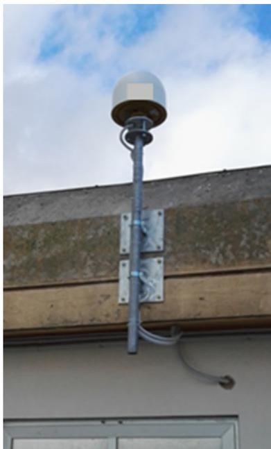
**Figura 2 – Esempio di installazione di una stazione GNSS**
