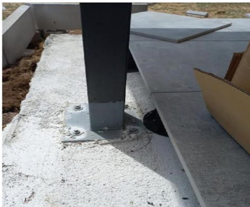
Dettaglio base del pilastro con piastra e contro piastra imbullonata
