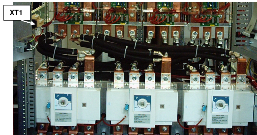
Fig. 25 – Posizione del morsetto di segnale XT1 – Taglia 600/800A
