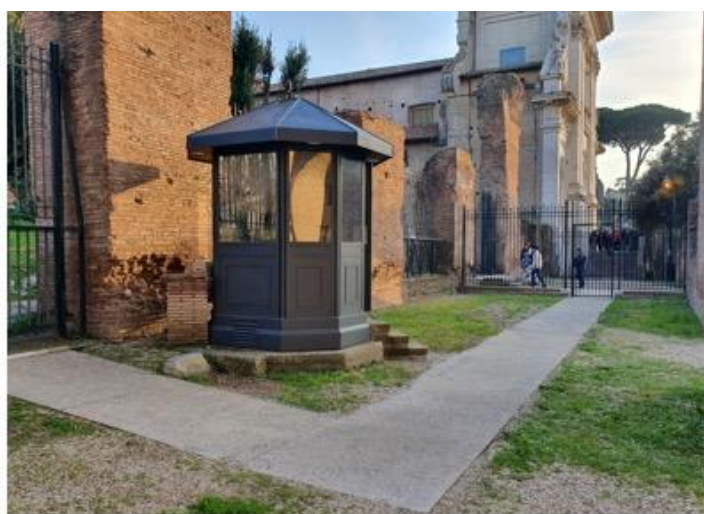
Struttura esistente presso uscita Massenzio
